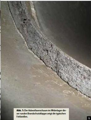
Abb. 1: Der Asbestfreeschaum im Widerlager dieser runden Brandschutzklappe zeigt die typischen Fehlleiten.
