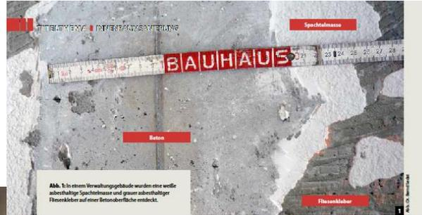
Abb. 1: In einem Verwaltungsgebäude wurden eine weiß-schattige Spachtelmasse und grauer selbsthaftiger Fliesenkleber auf einer Betonoberfläche entdeckt.
